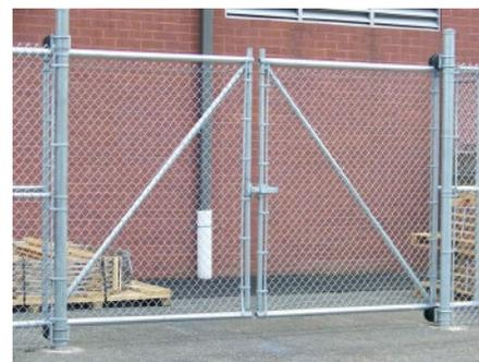
El tubo galvanizado para cerca es el más utilizado para usos en la intemperie ya que no necesita mantenimiento como pinturas anticorrosivas lo cual ayuda en la economía, es utilizado para la fabricación de cercas perimetrales, para hacer brazos para lámparas.
